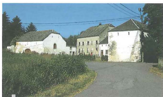
Grosse ferme en carré à Schockville
